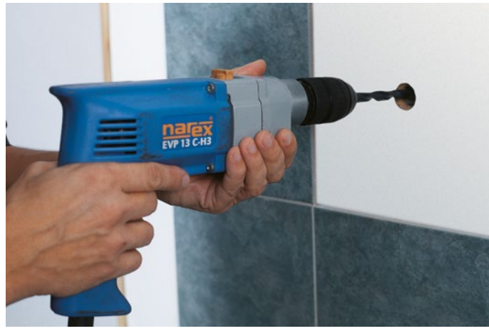
1/ Пробитият отвор се разширява (калибрира) със свредло 10 мм
