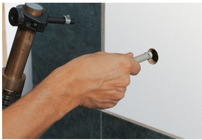
4/ Нагретият ремонтен прът се изважда от накрайника и без завъртане се поставя в нагретия отвор.
