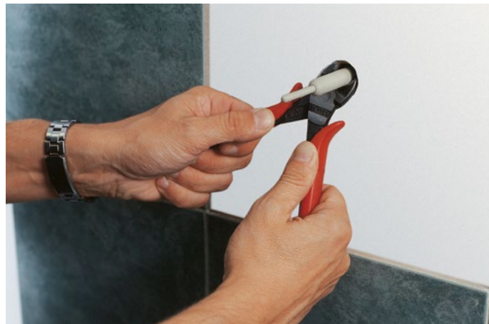
5/ След охлаждане ненужната част на пръта се изрязва с ножица.
