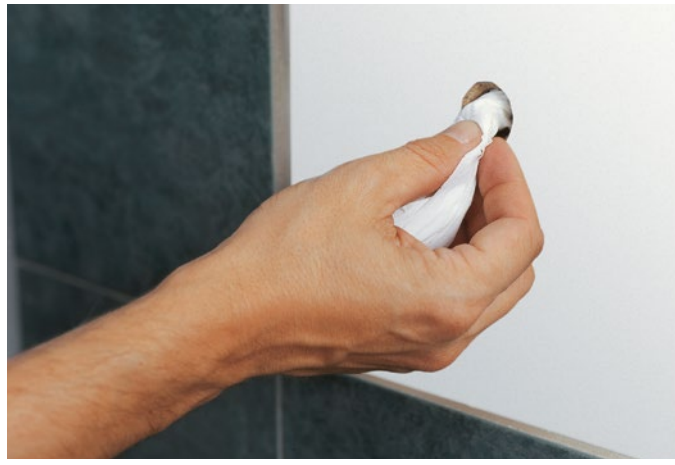
2/ Разширеният отвор се подсушава и обезмаслява. Върху ремонтния прът се маркира разстоянието, равно на дебелината на стената на пробитата тръба + 2 мм (дълбочина на монтаж). На същото разстояние върху накрайника се поставя ограничителен пръстен.
