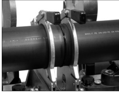
Охлаждение сварного шва
