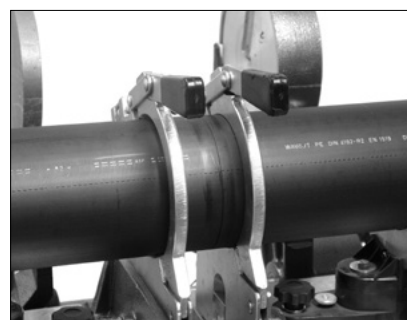
Трубы, правильно подготовленные к сварке
